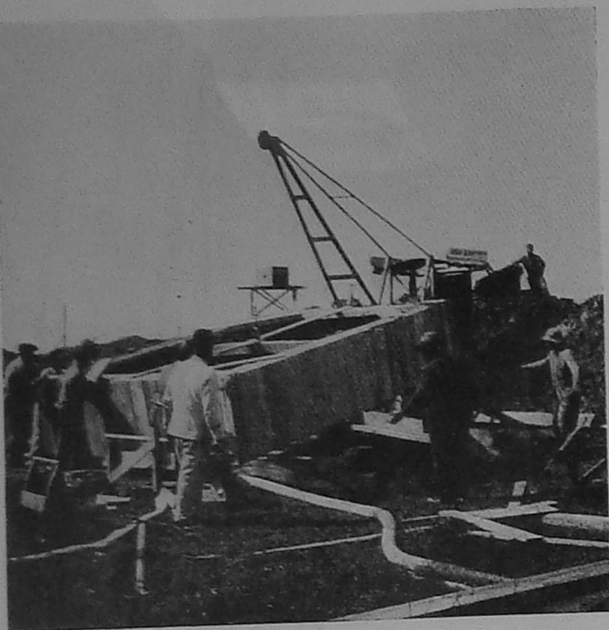
Excavación de los pozos para fundación de los pilares de las tribunas. Manejo de formas rígidas para contención de las tierras en el pozo.
