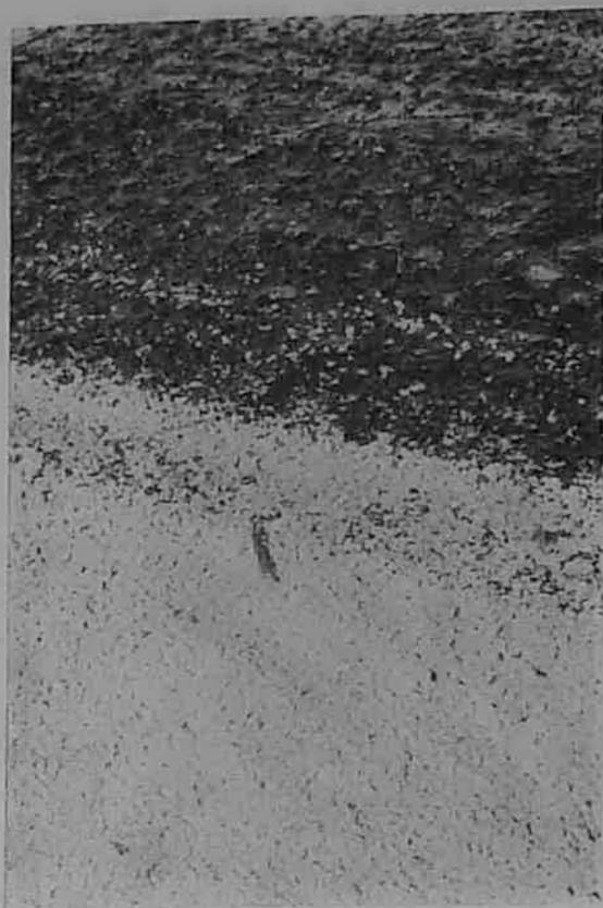
FIG. 7. — Distribución de agregado pétreo sobre una superficie previamente imprimada: al fondo la misma.
