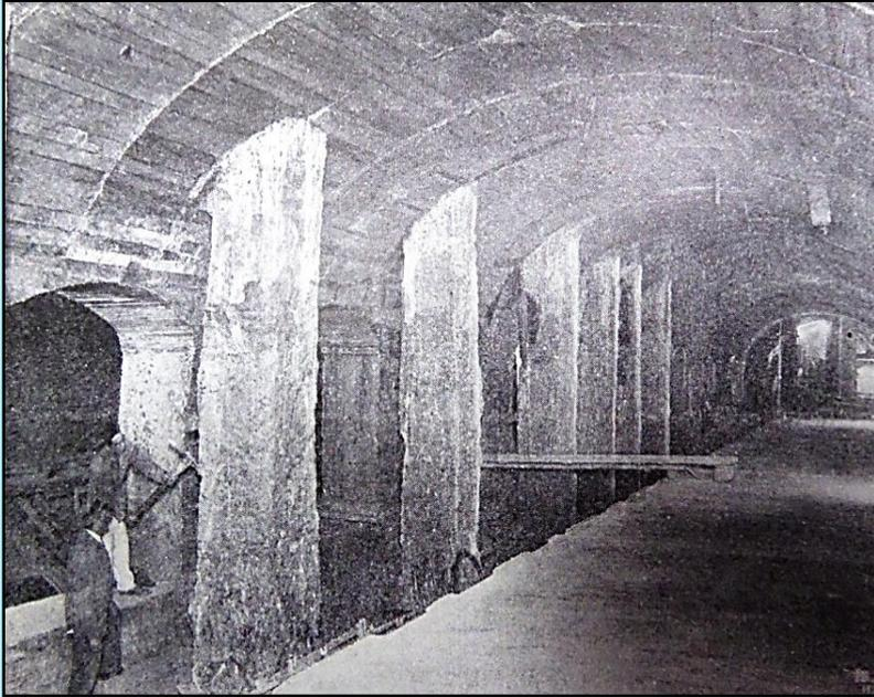
*Pilares auxiliares de sub muración de un edificio en la estación Lavalle. Una vez hormigonada la bóveda se cortaban los pilares de refuerzo haciéndose incidir así la carga directamente sobre el túnel.*
