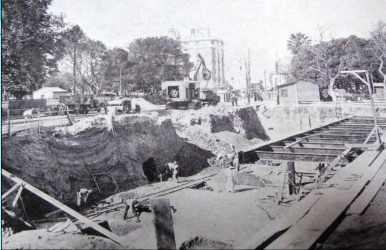
*Excavación a cielo abierto para la construcción de la estación Constitución. (Fuente la Construcción de los Subterráneos*
