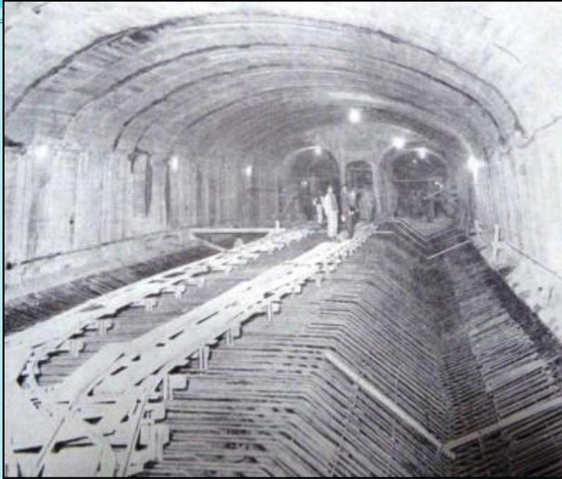
*Estación en construcción, puede apreciarse la solera preparada para ser hormigonada. Nótese la fuerte armadura, necesaria para resistir la supresión.*
