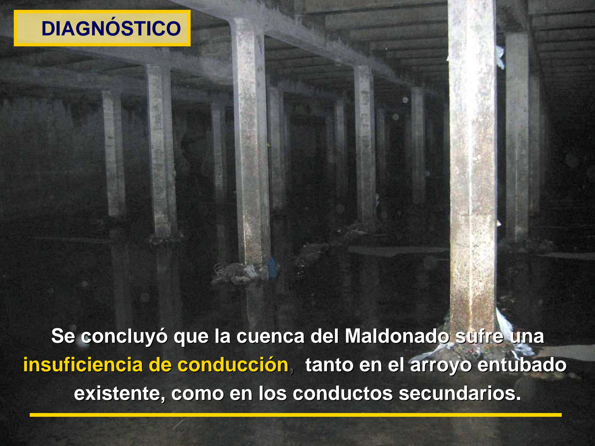
Se concluyó que la cuenca del Maldonado sufre una **insuficiencia de conducción**, tanto en el arroyo entubado existente, como en los conductos secundarios.
